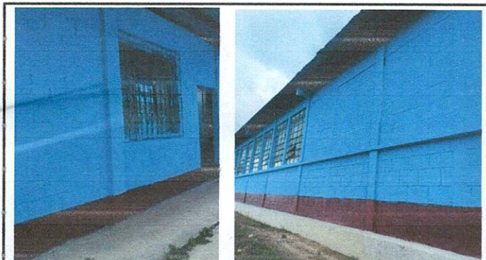
Foto 3: Se instalaran 3 ventanas en el aula de computacion y tambien se colocaran balcones.
