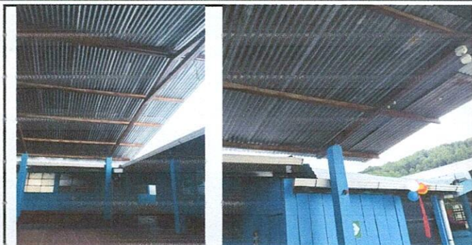
Foto1: Se cambiara la cubierta de lamina del techo del escenario y corredor de la escuela
