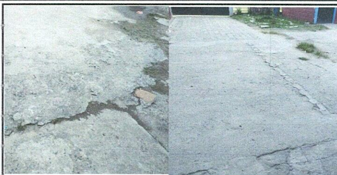
Foto 2: Se realizara mejoramiento e instalacion de piso en el corredor y entrada del centro educativo
